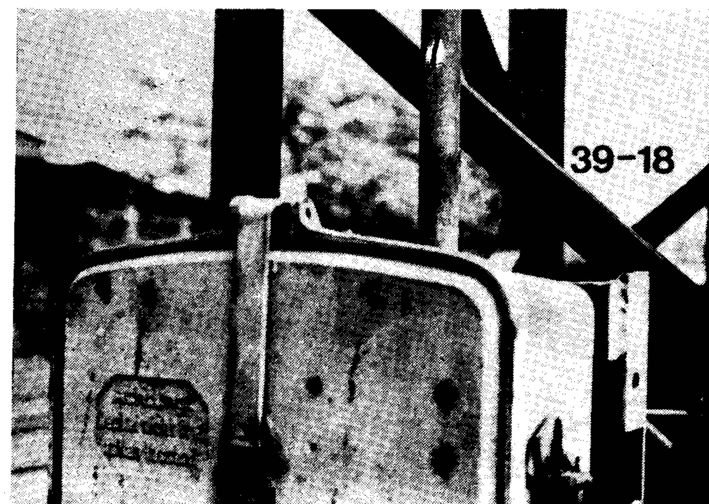
Slika 44 POLOŽAJ POLUŽJA MOTORNOG POGONA RASTAVLJAČA KOJI (crve- na oznaka nije vidljiva) OZNAČAVA DA JE RASTAVLJAČ U POLOŽAJU »ISKLJUCENO«
